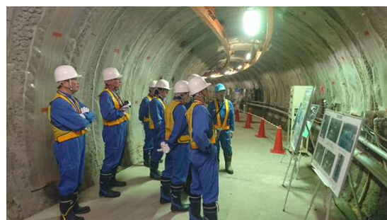
写真4 地下350mの坑道内を視察
